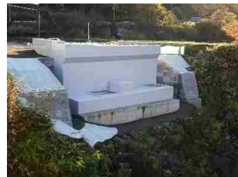
【浜岩橋右岸橋台の状況】
