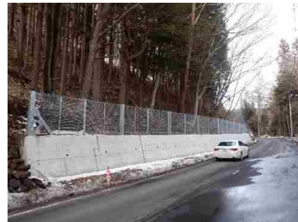
完成区間(落石防護柵)
