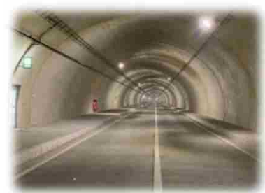
写真は供用しているトンネル内の写真です。
