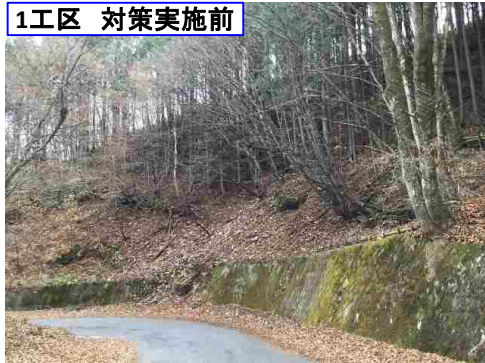
1工区 対策実施前
