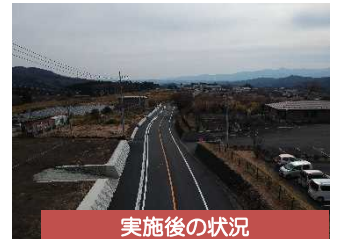
実施後の状況
