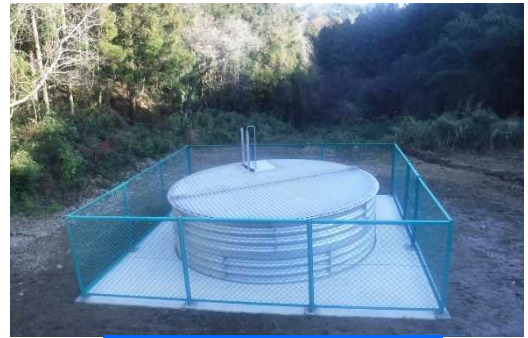
集水井A-1の完成状況（R3.3）
