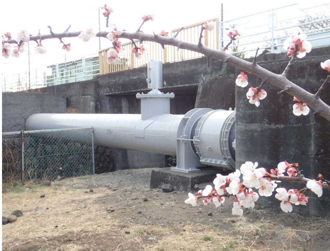
渋川工業用水道事務所 金沢川水管橋
