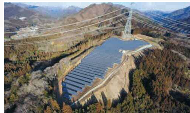
沢渡温泉第2太陽光発電所
