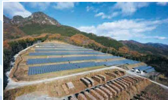
沢渡温泉第1太陽光発電所
