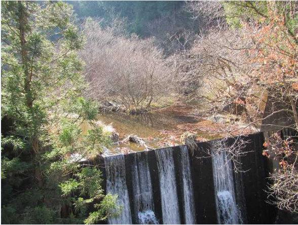
①堰堤上流側
