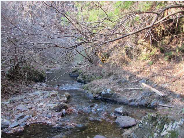
③堰堤下流側
