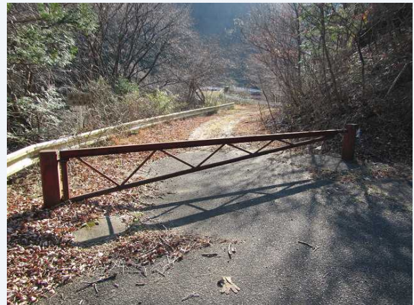
⑥既設アクセス道路出入口部 ゲート
