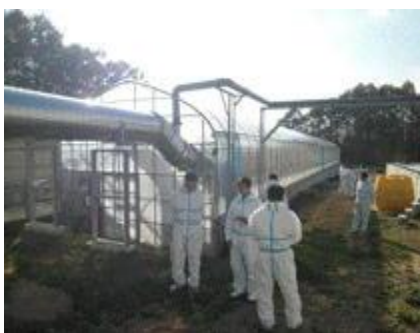
直線型堆肥化施設に設置
