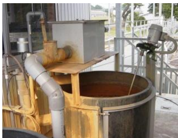
ポリ硫酸第二鉄添加高度処理装置
