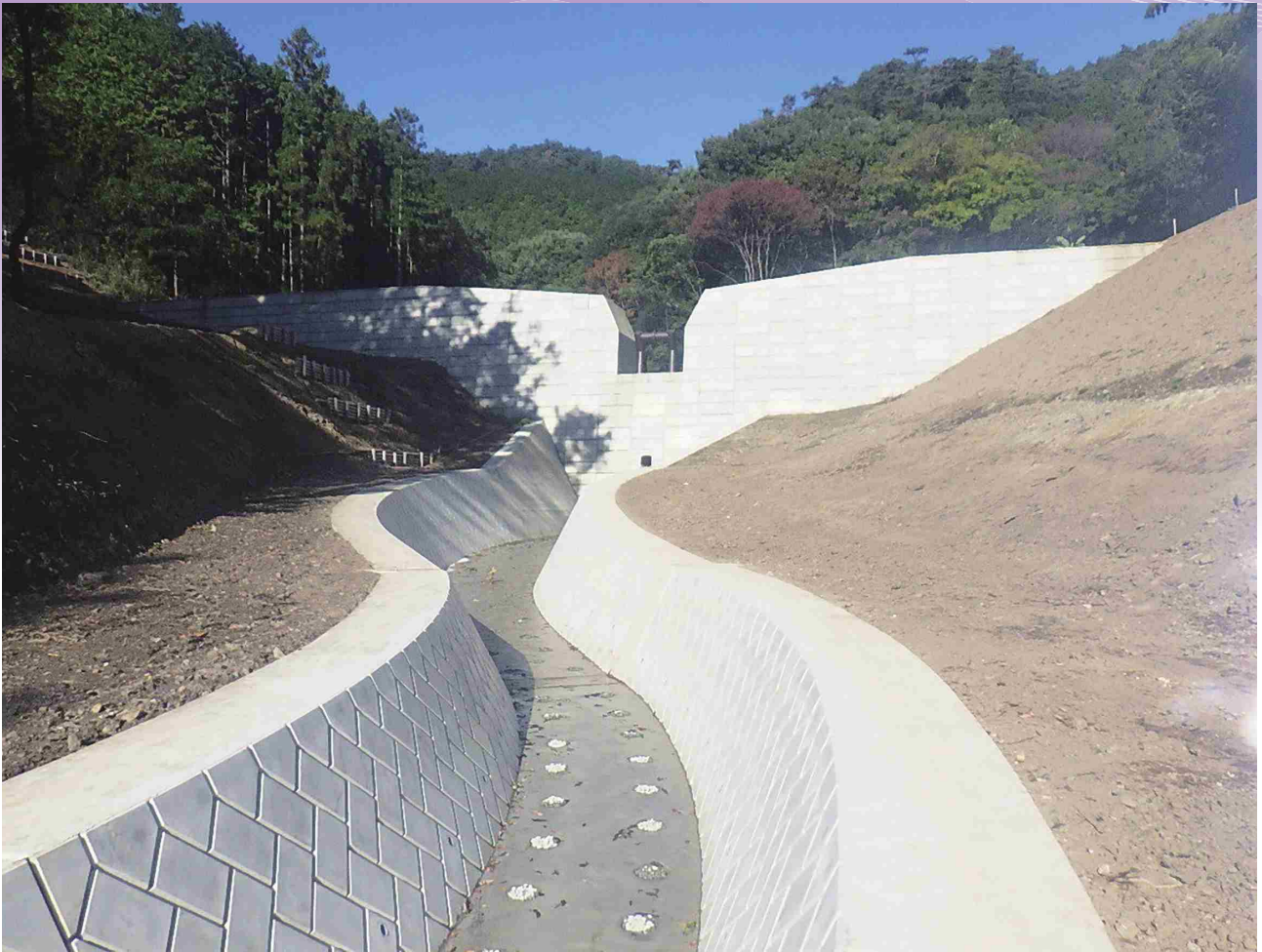
通常砂防事業『姥沢』（桐生市梅田町） 砂防えん堤（部分透過型）
