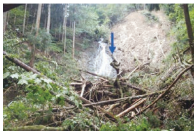
崩壊地と堆積した流木
