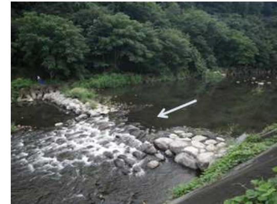
図 4.24 対策のイメージ（床固め工）
