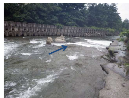
図 2.5 河床洗掘箇所
