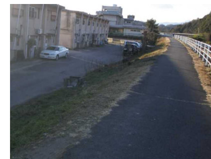
図 2.4 堤防浸透対策箇所
