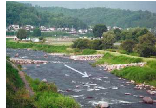
図 4.25 対策のイメージ（水制工）
