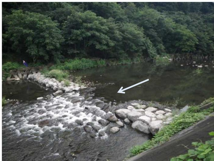
図 4.24 対策のイメージ（床固め工）
