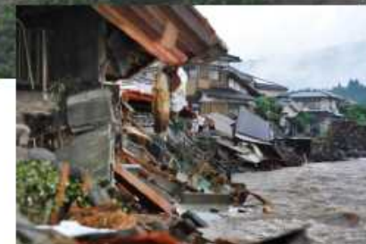
河岸侵食により家屋倒壊した状況
