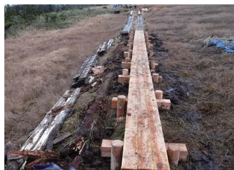
県管理木道修繕(横田代地区)
