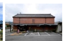
小幡組製糸 レンガ造り倉庫
