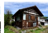
永井流養蚕 伝習所実習棟
