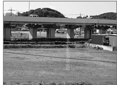
整備後の臨時駐車場
