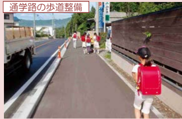
通学路の歩道整備
