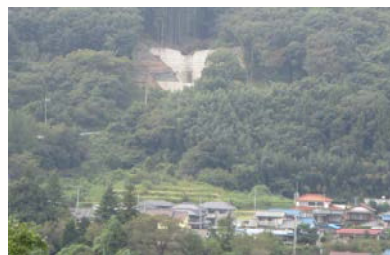
渡良瀬川水系 中井沢 砂防堰堤 (みどり市)
