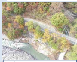
吾妻川 被災状況(長野原町)
