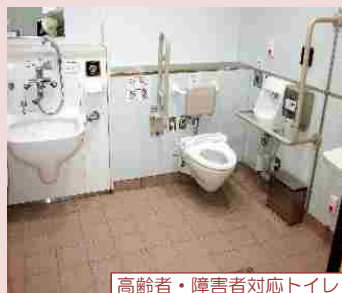
高齢者・障害者対応トイレ
