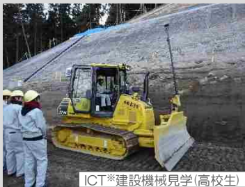
ICT建設機械見学(高校生)
