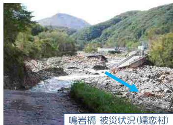
鳴岩橋 被災状況(嬭恋村)
