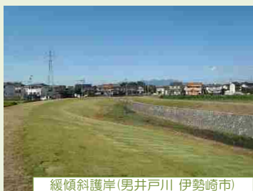
緩傾斜護岸(男井戸川 伊勢崎市)
