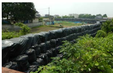
一級河川 八瀬川 土嚢による堤防緊急嵩上げ (太田市)
