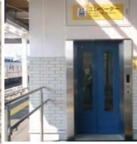
鉄道駅のバリアフリー化 （エレベータ設置）
