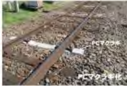
マクラギの老朽化に伴う更新
