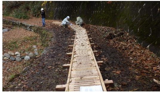
図6 試験設置した木道 (下流側)
