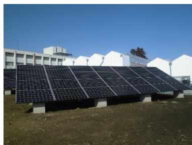
温室用の電気等に使用するソーラー発電システム
