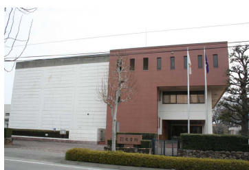
外壁改修後の文書館
