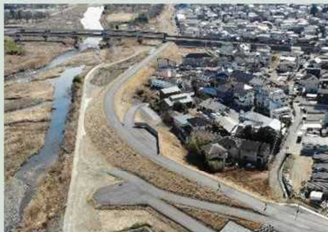
烏川堤防整備
