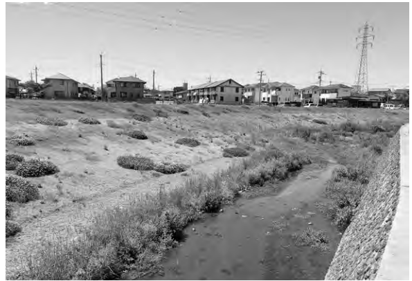
一級河川寺沢川 前橋市
