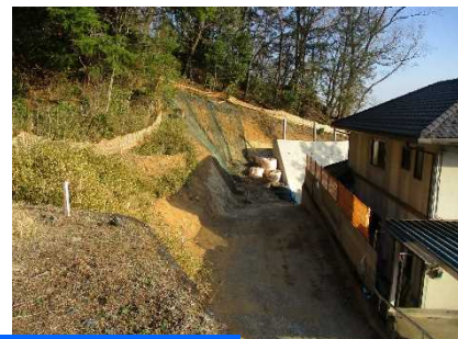
R4年度施工箇所
