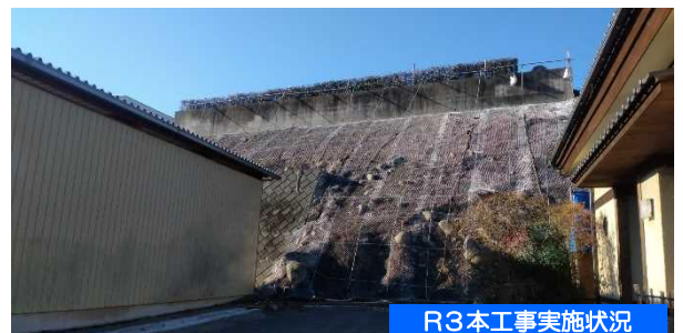
R3本工事実施状況
