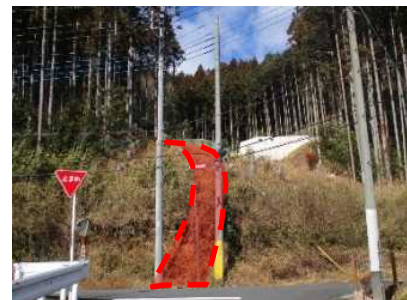
溪流保全工施工箇所
