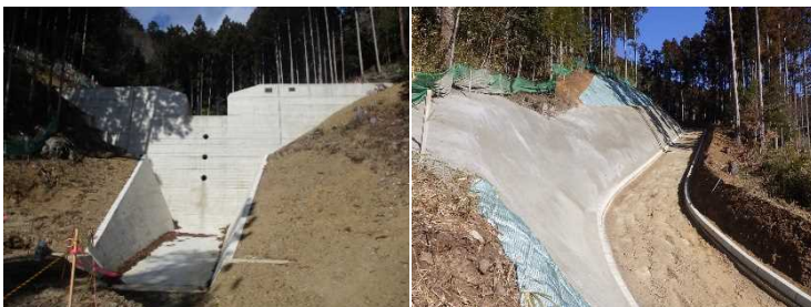
施工状況（R4年3月現在）
