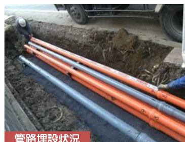
管路埋設状況
