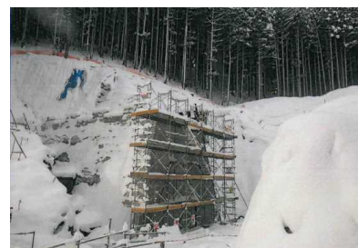
砂防堰堤施工状況
