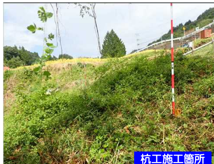
杭工施工箇所
