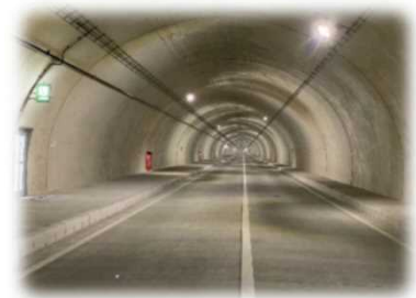
写真は供用しているトンネル内の写真です。
