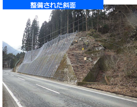
整備された斜面
