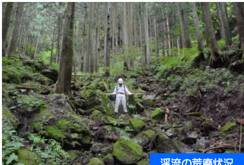
溪流の荒廃状況
