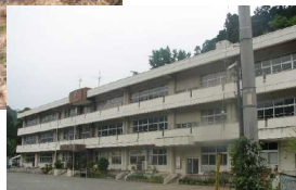
保全対象(避難所)
