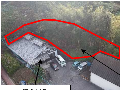
保全対象 要配慮者施設
