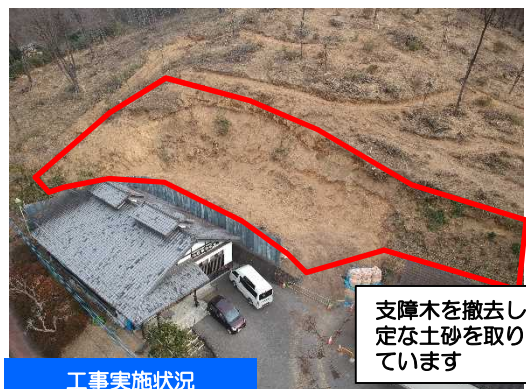
工事実施状況
