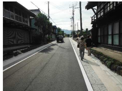
完成後の状況
