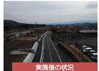
実施後の状況
