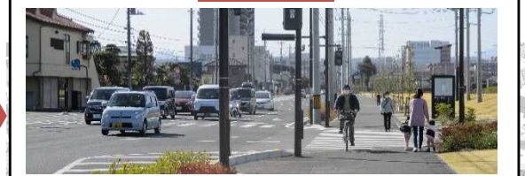
完成後の状況
