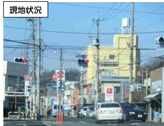
乱立する電柱・電線類
