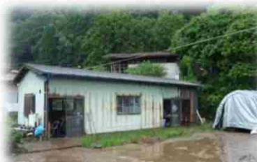
被災状況・床下浸水
