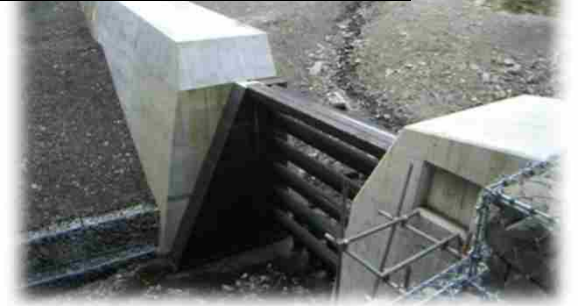
土石流発生前【令和元年9月完成】
