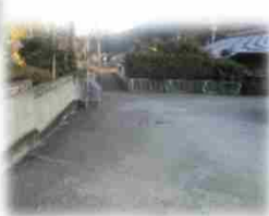
避難経路 (町道)
