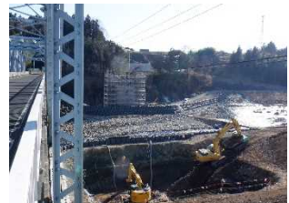
R2 橋脚工事の実施状況
