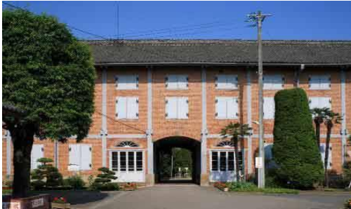
国重要文化財・史跡「富岡製糸場」(富岡市)
